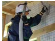
断熱吹き込み作業
